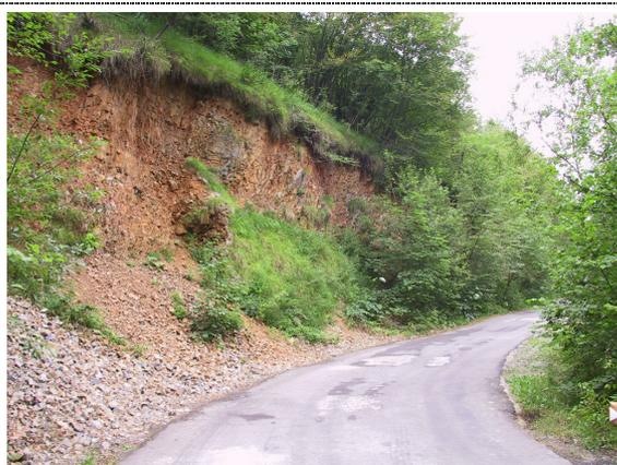
*Foto 38: Fronte di scavo instabile lungo la strada che conduce alla Madonna d'Erba in prossimità del ponte sulla Valle delle Sponde.*
