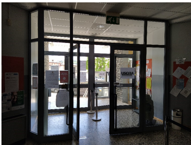
Serramento interno di ingresso, esistente
