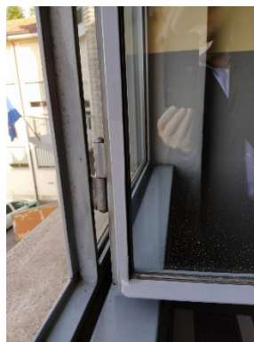
Serramento esistente 160x160cm a servizio degli uffici a piano rialzato
