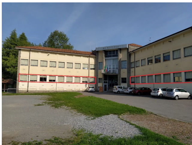
18 Serramenti esistenti 160x160cm a servizio degli uffici a piano rialzato
