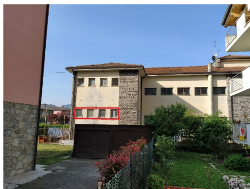
4 Serramenti esistenti 95x105 bagni est piano rialzato
