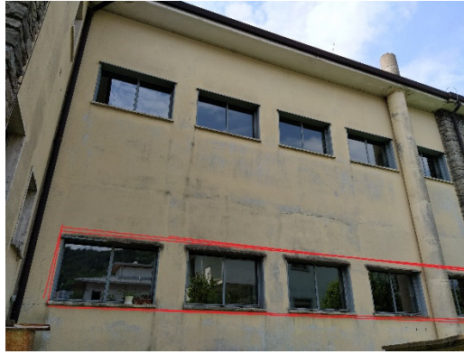
Serramenti esistenti 160x100 sul fronte posteriore, piano rialzato
