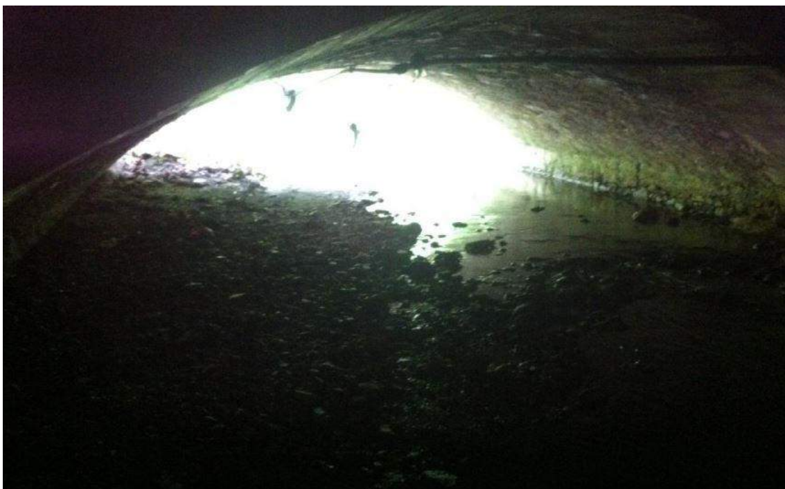
Fig. 9 - Attraversamento strada provinciale in corrispondenza del Torrente Re (vista da valle)
