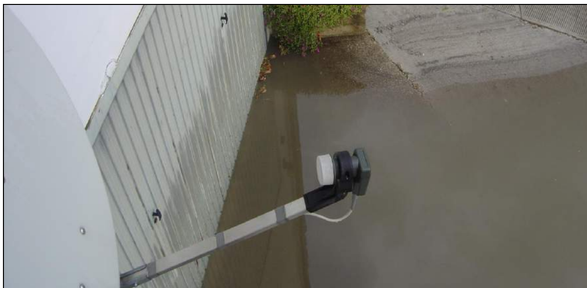
Fig. 16 – allagamenti di garage – immagine fornita dall'Ufficio Tecnico del Comune di Leffe
