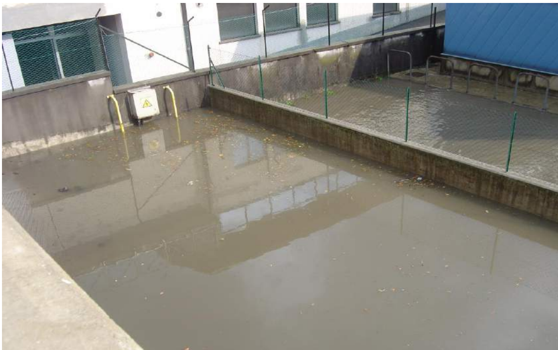
Fig. 17 – allagamenti aree produttive – immagine fornita dall'Ufficio Tecnico del Comune di Leffe
