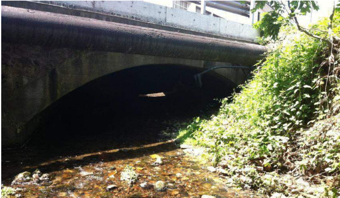
Fig. 8 – Attraversamento strada provinciale in corrispondenza del Torrente Re (vista da monte)
