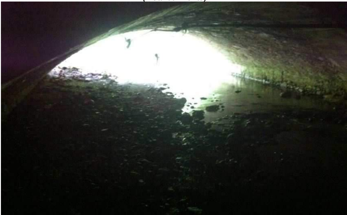
Fig. 25 - Attraversamento strada provinciale in corrispondenza del Torrente Re (vista da valle)
