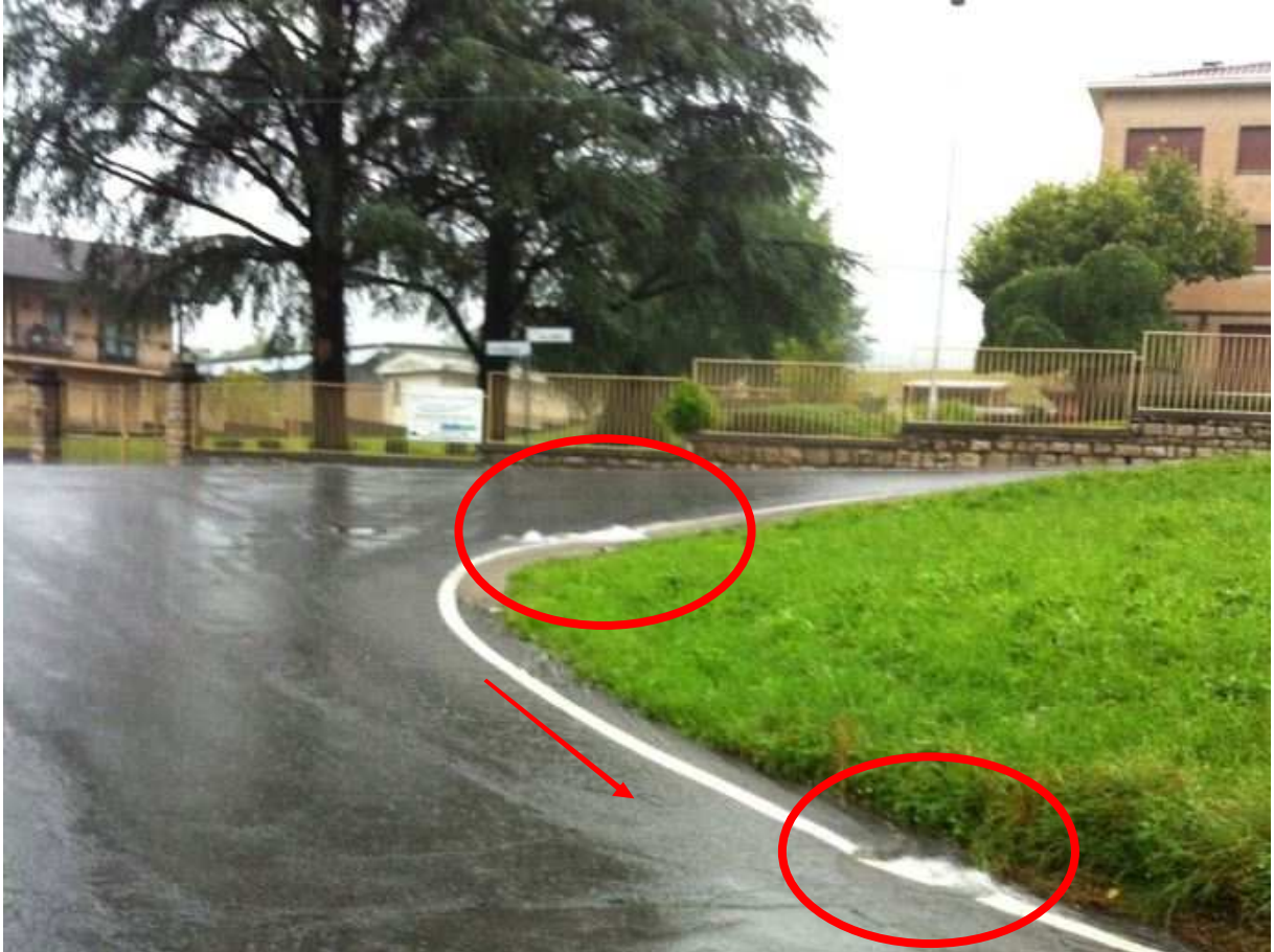
Fig. 29 – ruscellamenti lungo la strada che da via Cav. Radici di Cazzano S.A. conduce verso Leffe (via Fornaci) e fuoriuscita degli apporti fognari dalle caditoie in corrispondenza di eventi meteorici intensi di agosto 2016
