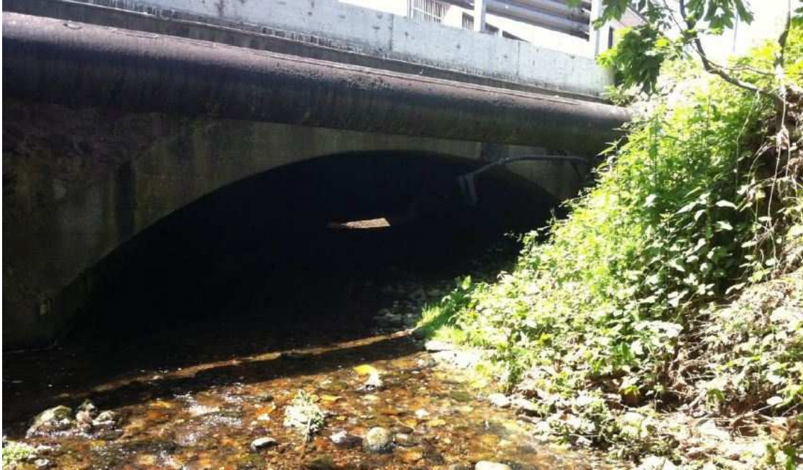
Fig. 24 – Attraversamento strada provinciale in corrispondenza del Torrente Re (vista da monte)
