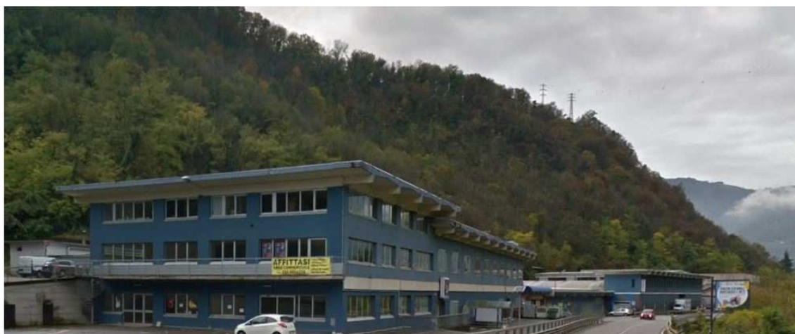
Fig. 17b – Comparto industriale di via lungo Romna
