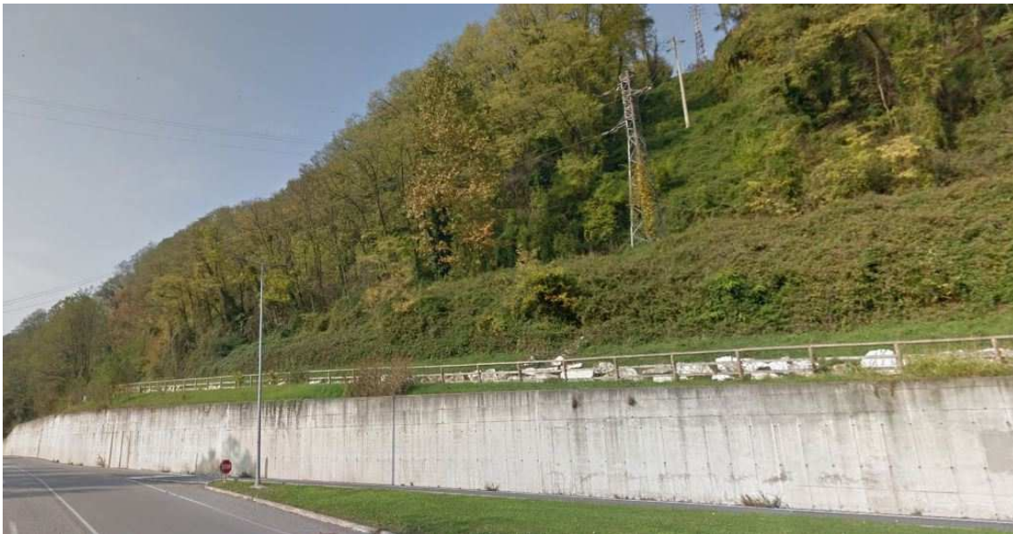
Fig. 21f – Percorso pedonale del fondovalle del Romna (Valgandino)
