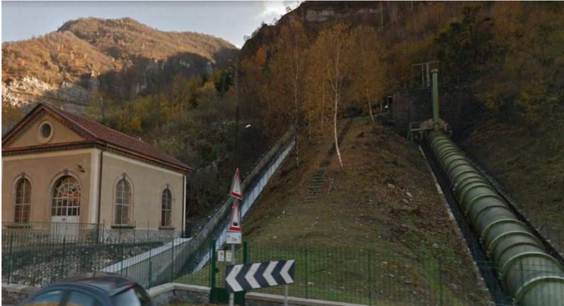
Fig. 22a – Condotta forzata di una centrale idroelettrica in via Serio nei pressi del Ponte del Costone
