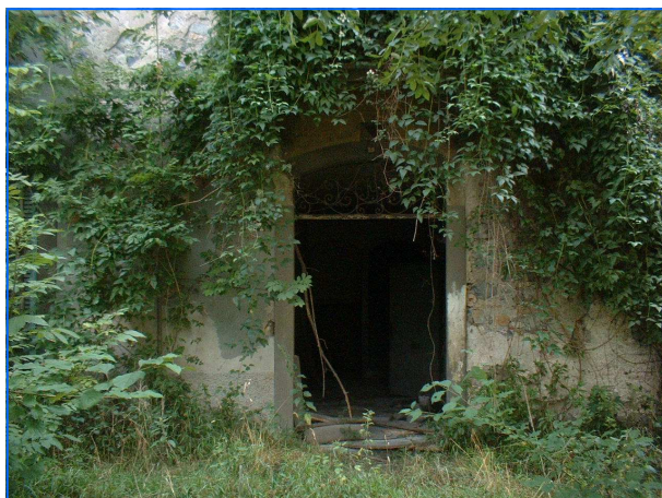
◀ Ingresso principale a pianterreno lato sud
