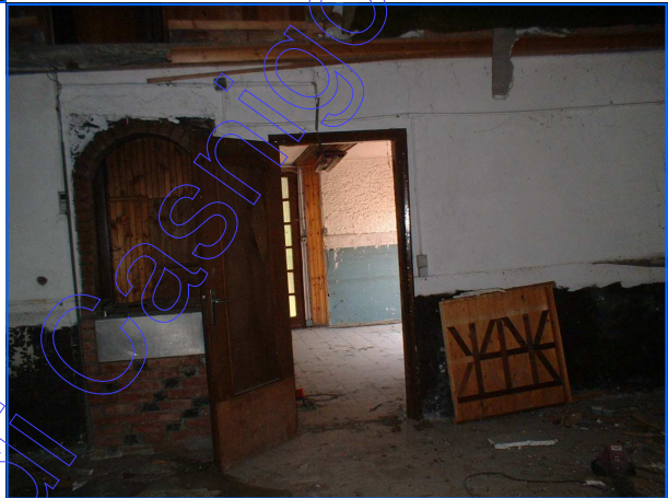
Sala interna a pianterreno ▶
