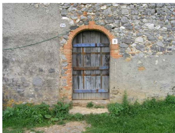
Particolare prospetto nord-ovest
