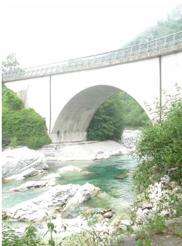
Il ponte ripreso da sud-est
