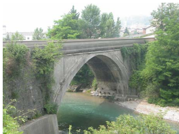
Il ponte ripreso da nord-est
