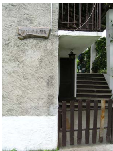
Particolare prospetto nord-ovest
