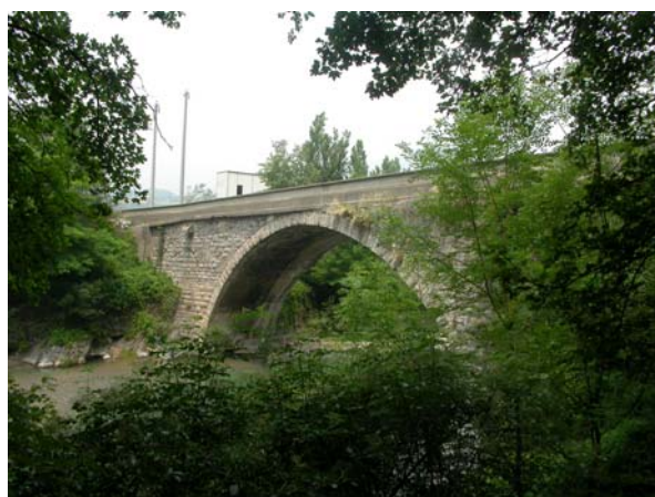
Il ponte ripreso da sud-est
