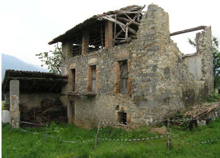
Ripreso da sud-ovest (corte)
