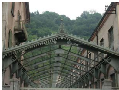
95 particolare struttura in ferro
