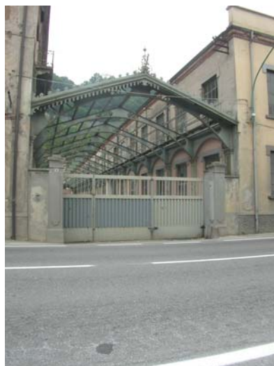
95 struttura in ferro
