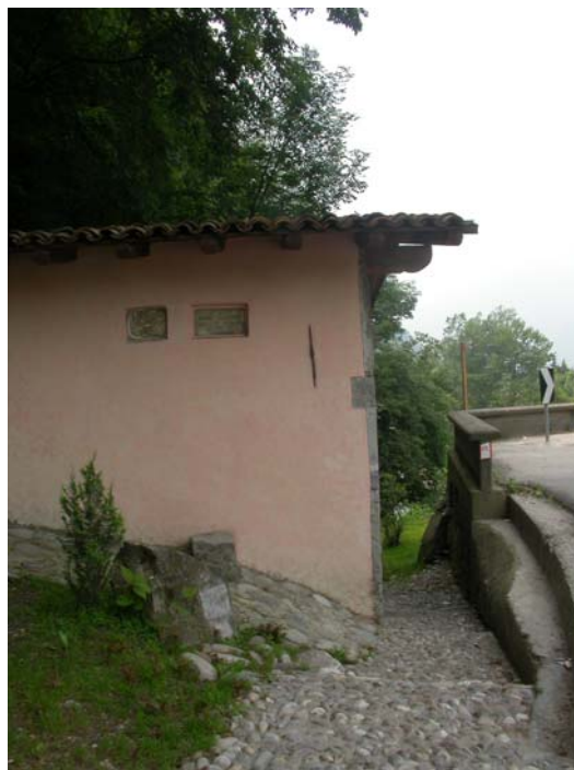
La cappella ripresa da nord
