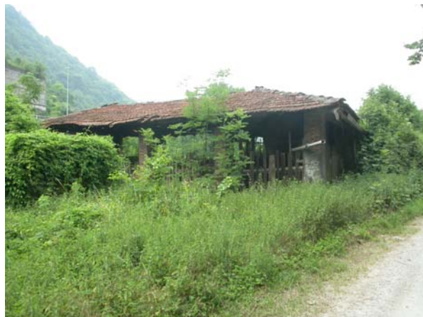
96 ripreso da est dalla strada
