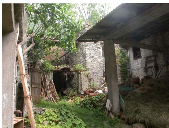
98 corte a nord, ripreso verso est
