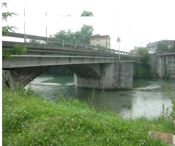
Il ponte ripreso da nord-est
