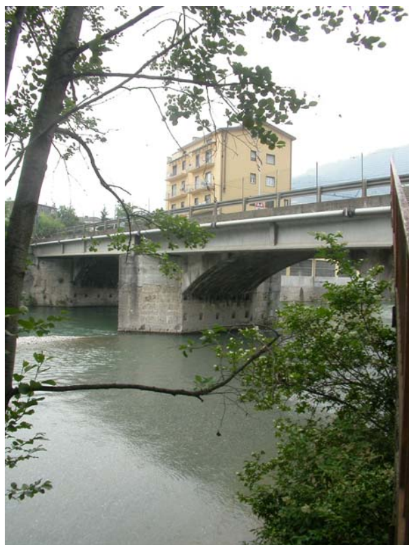
Il ponte ripreso da sud-est
