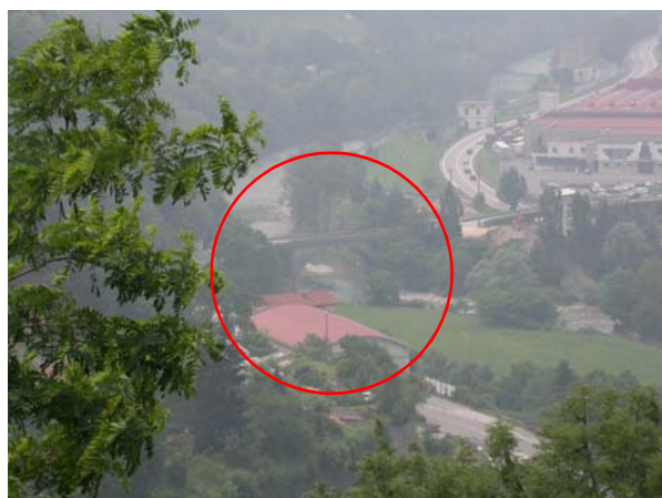
Il ponte ripreso dalla località Cascine Castello
