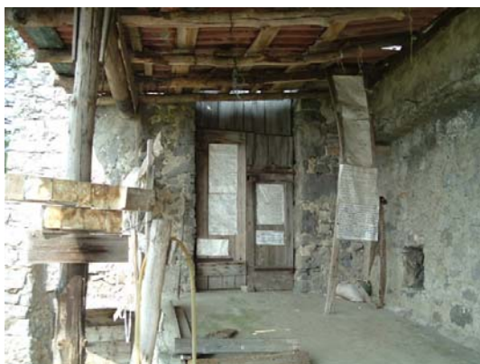
Particolare prospetto sud-ovest
