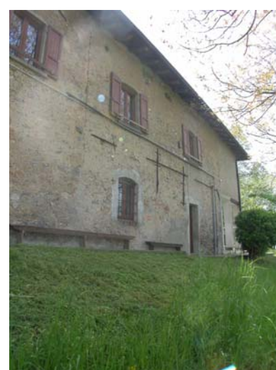
6b Corpo a nord ripreso da nord-est
