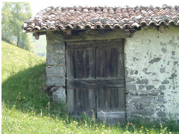
Particolare prospetto nord-ovest
