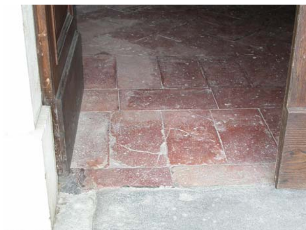
6a Pavimentazione interna
