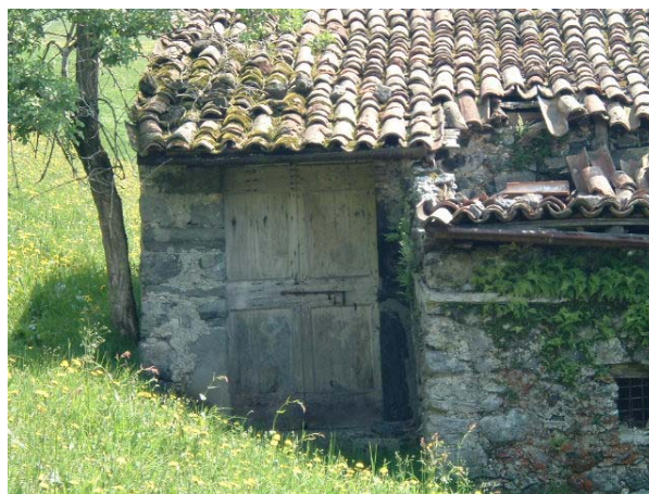
Particolare prospetto nord
