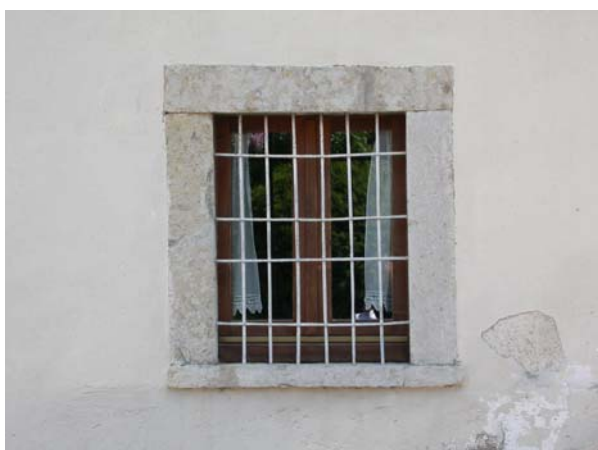
6a Finestra del prosp. ovest
