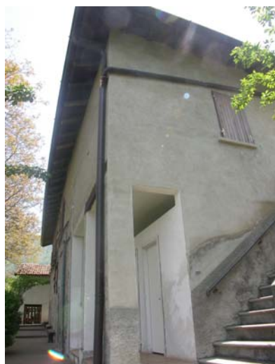
6b Corpo a nord ripreso da nord-ovest
