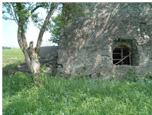
Particolare prospetto nord-ovest
