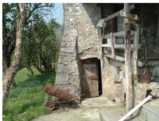
Particolare prospetto sud-ovest
