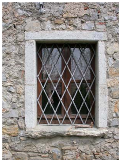
Particolare prospetto sud
