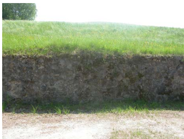
Muro di sostegno nel piazzale
