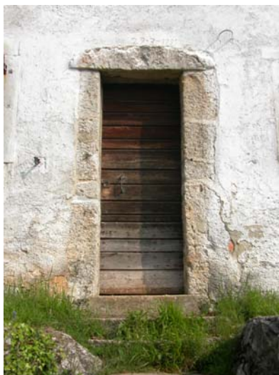
Particolare prospetto sud
