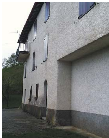
Particolare della muratura
