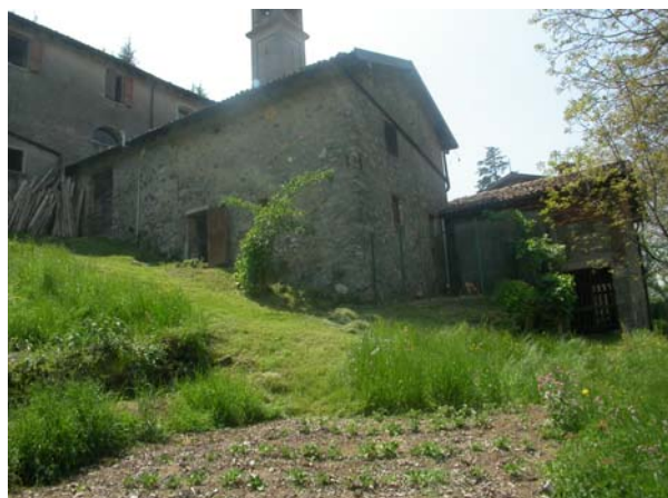
6b Corpo a nord ripreso da nord-est
