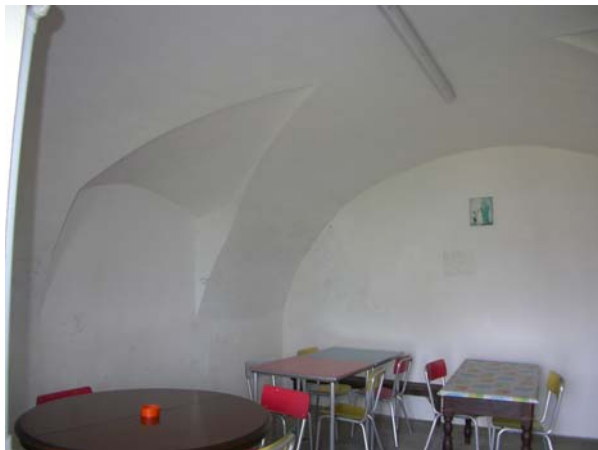
6b Locale voltato del corpo a nord
